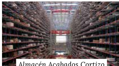
Almacén Acabados Cortizo
